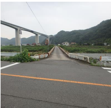
写真 補修工事対象の船木亀津橋
